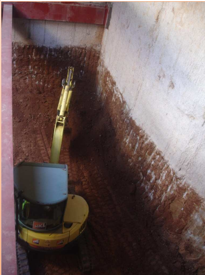
Foto 7. Vista del procés de rebaix a la segona fase de la sortida d'emergència.
