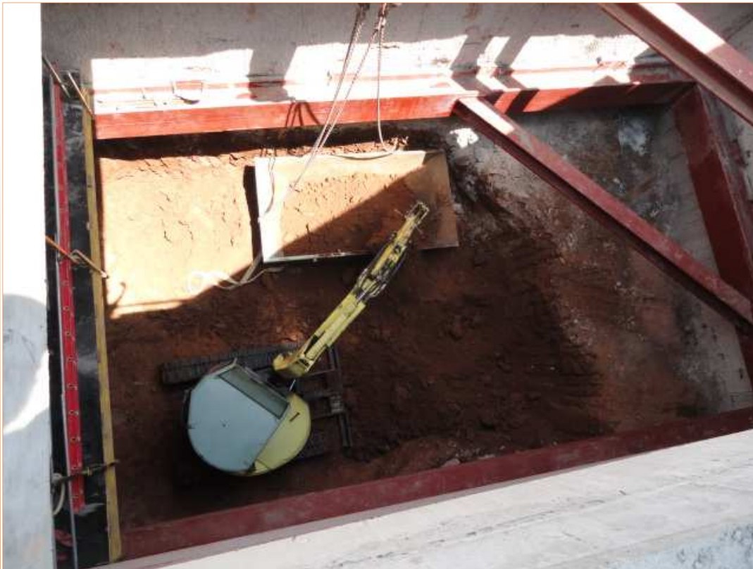
Foto 7. Vista del procés de rebaix a la segona fase de la sortida d'emergència.
