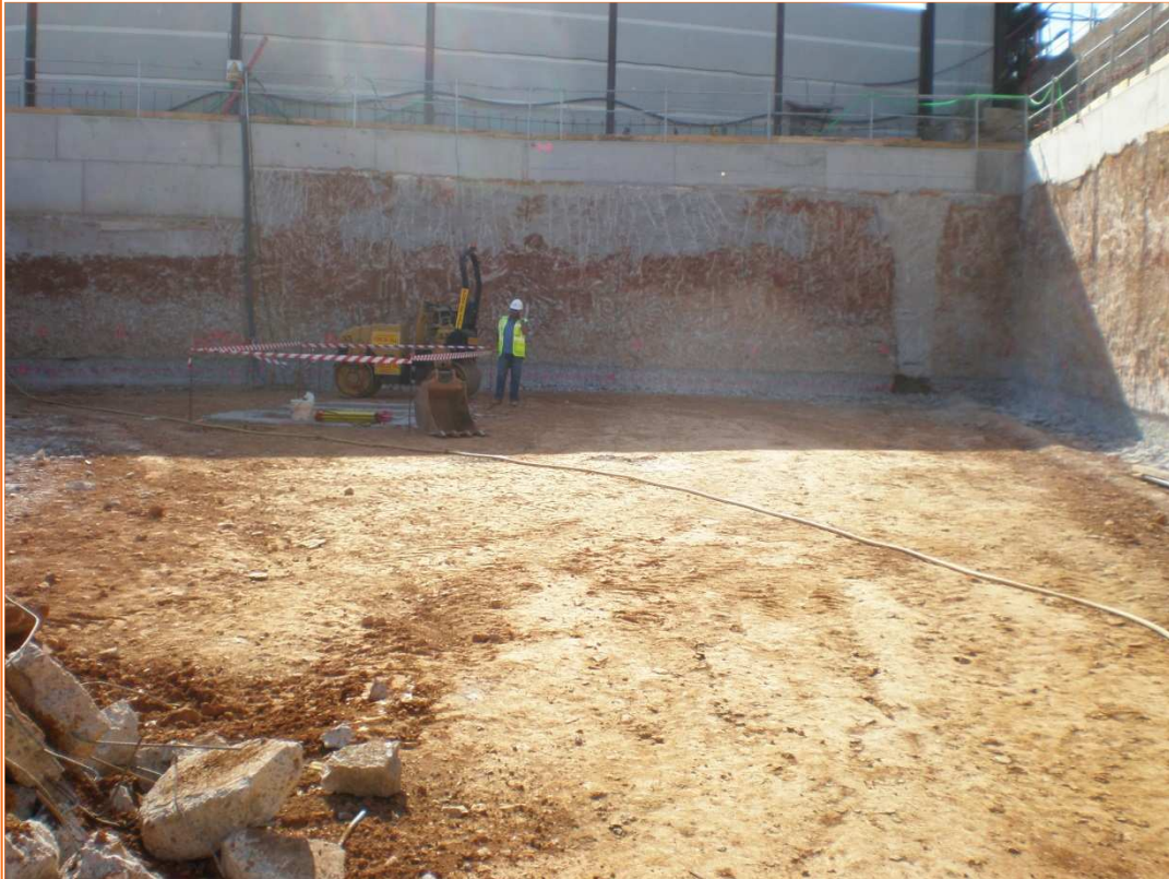
Foto 3. Vista des de l'est de la part nord-oest del solar al final de l'excavació del dia 4 d'octubre.
