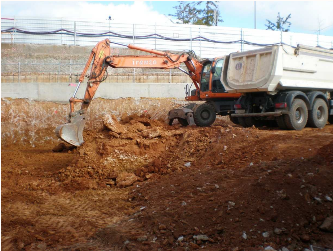
Foto 1. Vista general de la màquina giratòria durant l'extracció mecànica de la terra del solar del vestíbul.
