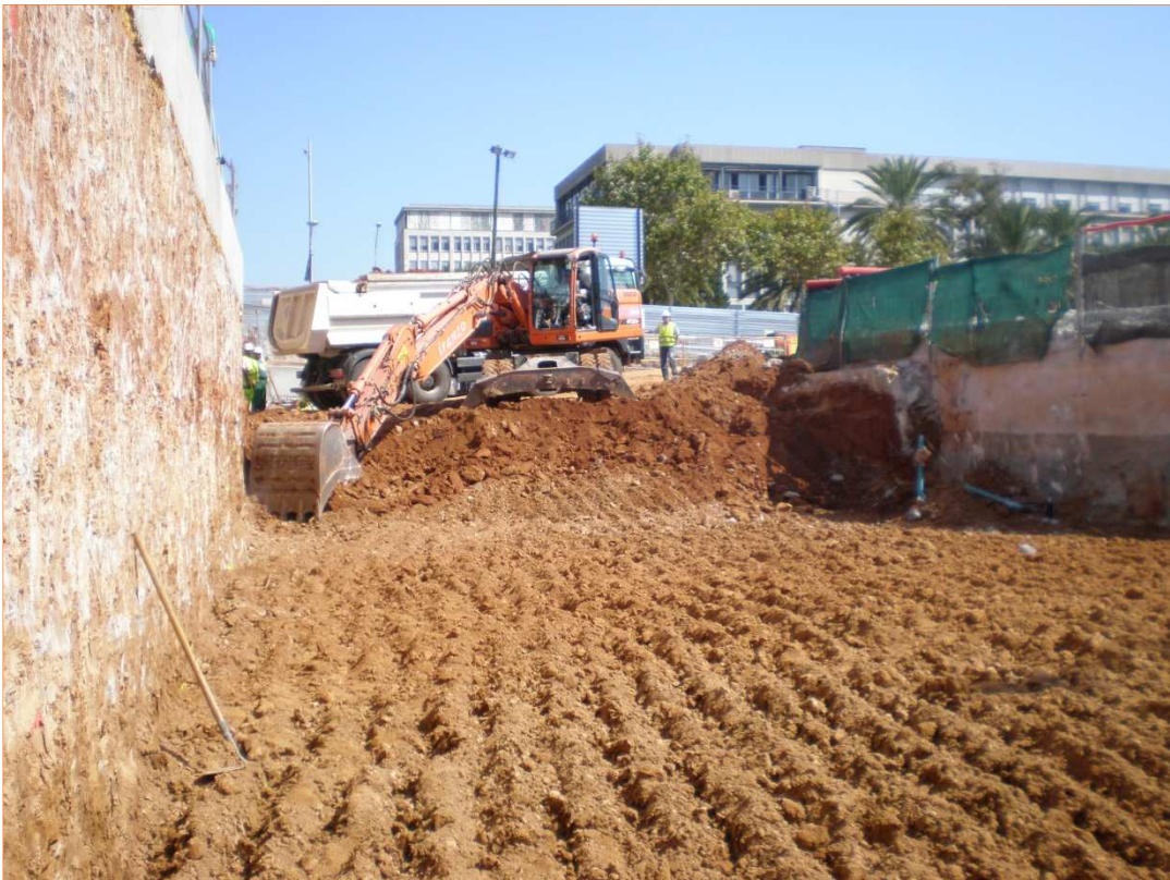
Foto 2. Vista des de l'oest dels treballs mecànics d'extracció de terra del vestíbul.
